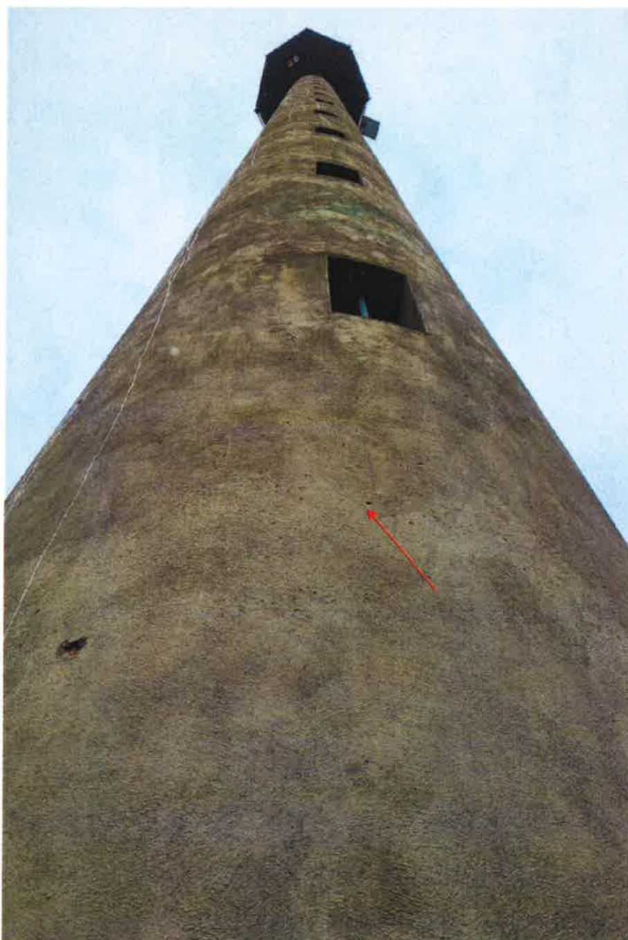
Fot.8 Widok na uszkodzenie zewnętrz - ubytki
